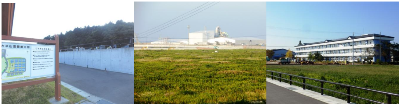
左：新設された大平山の町営墓地 中：仮設の災害廃棄物処理施設 右：幾世橋の集団移転先用地 奥は浪江東中学校で、幼・小・中学校の再開が検討されている
