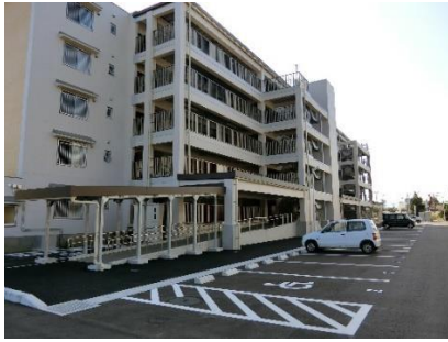
増築された共用廊下とエレベーター
