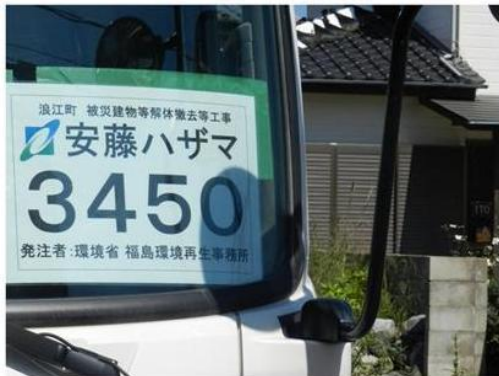
業者による家屋解体処理現場
