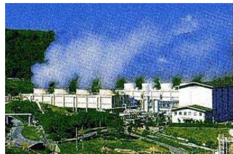
八丁原地熱発電所
