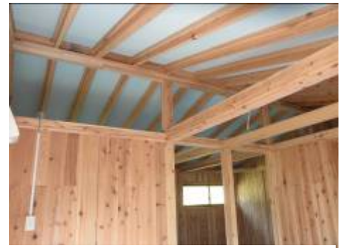
木造の応急仮設住宅
