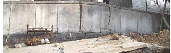
P8 造成地における建物傾斜被害、仙台折立
