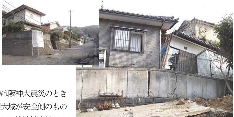
P8 造成地における建物傾斜被害、仙台折立
