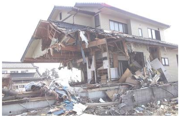
P3 木造家屋の被害、左側が海岸、名取
