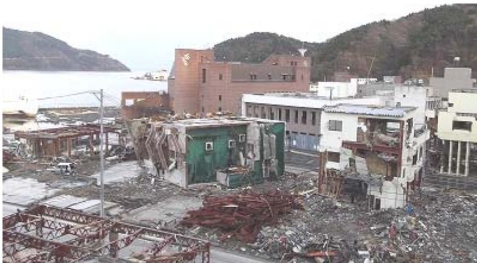
P1 中央に横転RC建物、右側にS造建物被害、女川撮影場所の高台まで浸水
