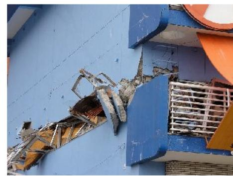
大和町5丁目の14階建てマンション ブルーシートで覆われた開口部の被害が全戸に見られる。
