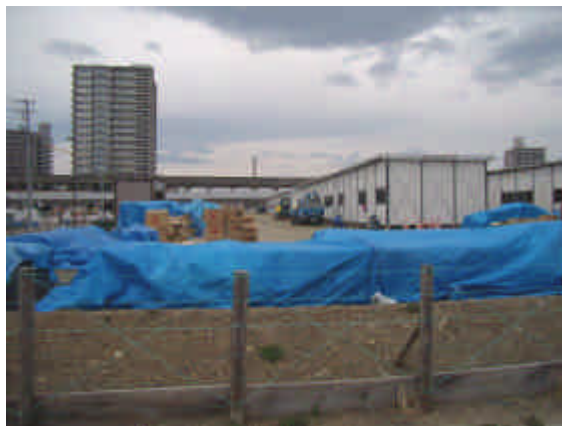
仙台市長町地区の応急仮設住宅
