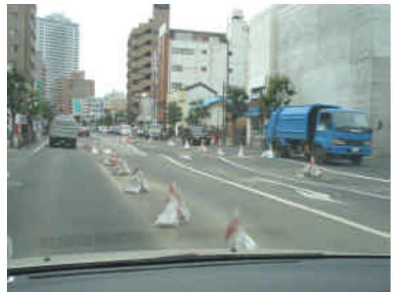
仙台市長町地区の液状化被害
