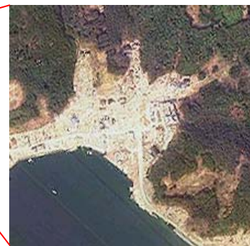
写真 3-2. 石巻市雄勝地区の全景と高地集落の家屋が集中して建設された□部の詳細
