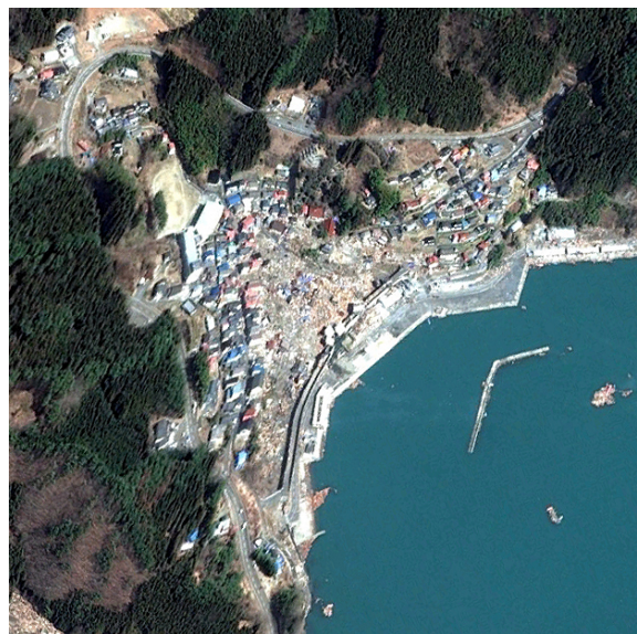
写真 6. 岩手県釜石市唐丹町小白浜地区の現況。
