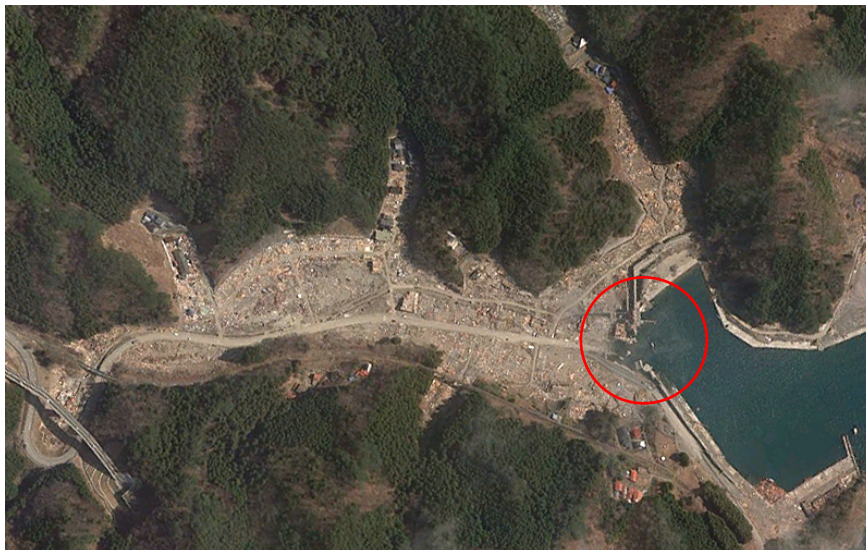
写真 7. 岩手県釜石市両石地区の現況。
